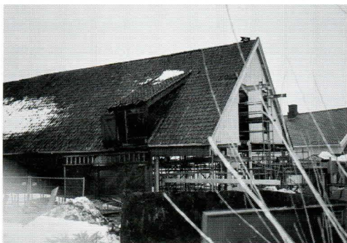
Bare taket syntes over gjerdet. Alt under forsvant fort da maskinene startet måltidet over 1705 byggverket.
